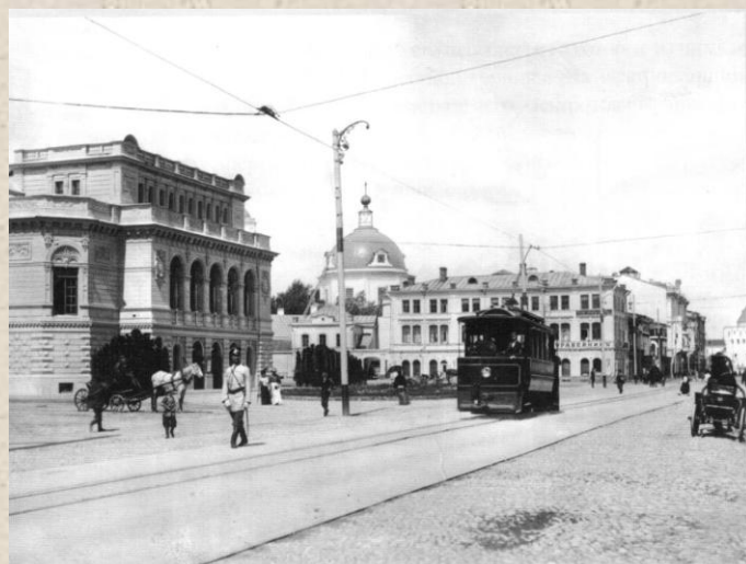
Однопутная линия узколинейного трамвая. «Эрликон» в движении. На заднем плане - церковь Николая Верхнепосадского
