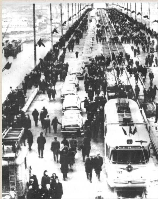
Первый вагон на Окском мосту.
