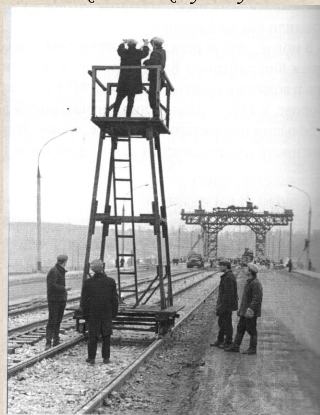
Монтаж контактной сети с лейтера. Шака называлась передвижная монтажная вышка.
