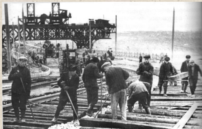
Последние метры. На строительстве подходов к Молитовскому мосту.
