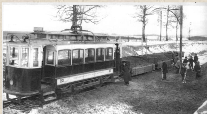
Балласт прибыл на строительство красноэтиновской линии
