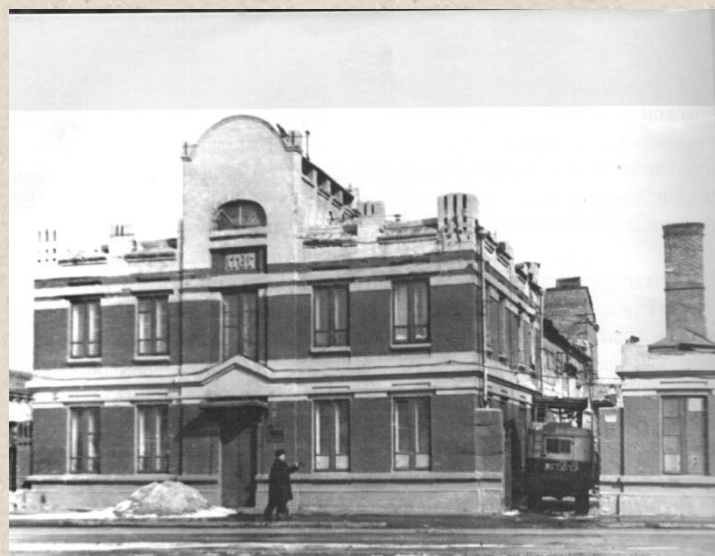
В здании Канавинской электростанции (примерно на месте сегодняшнего «Дома книги») до начала строительства площади Ленина располагалась служба энергохозяйства и тяговой подстанции №4
