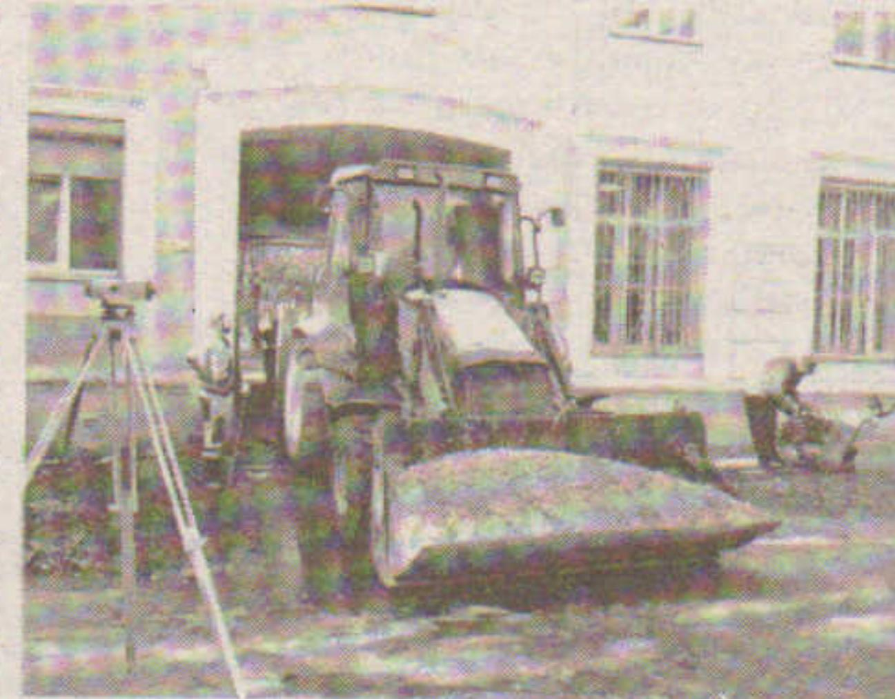
с одной стороны и проездной части – с другой. Вот почему там постоянно скапливалась вода. Специалисты сняли 200 кв. метров асфальта, чтобы вновь его уложить с нужным уклоном, который направит потоки воды в ближайшую ливневку», – рассказал Владимир Кропотин.
