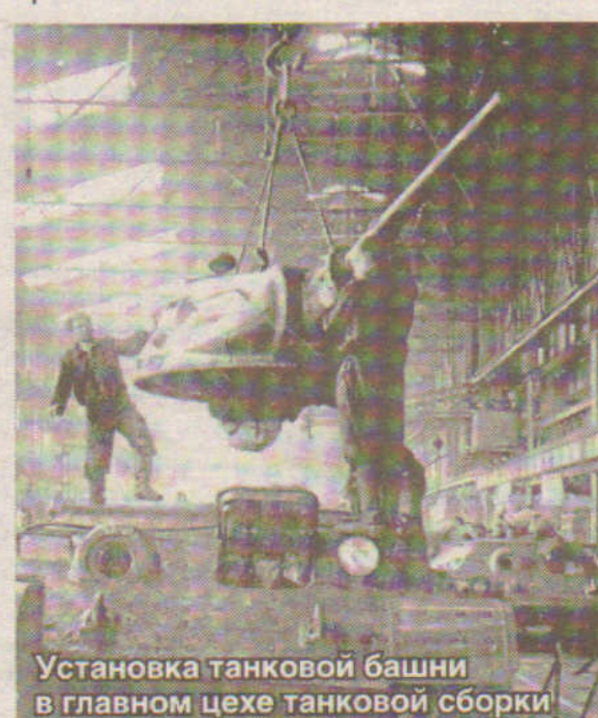
Установка танковой башни в главном цехе танковой сборки
